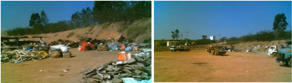
Figura 3: Chegada e Pré-triagem de resíduos da construção civil, Cooperativa Tatuapé
