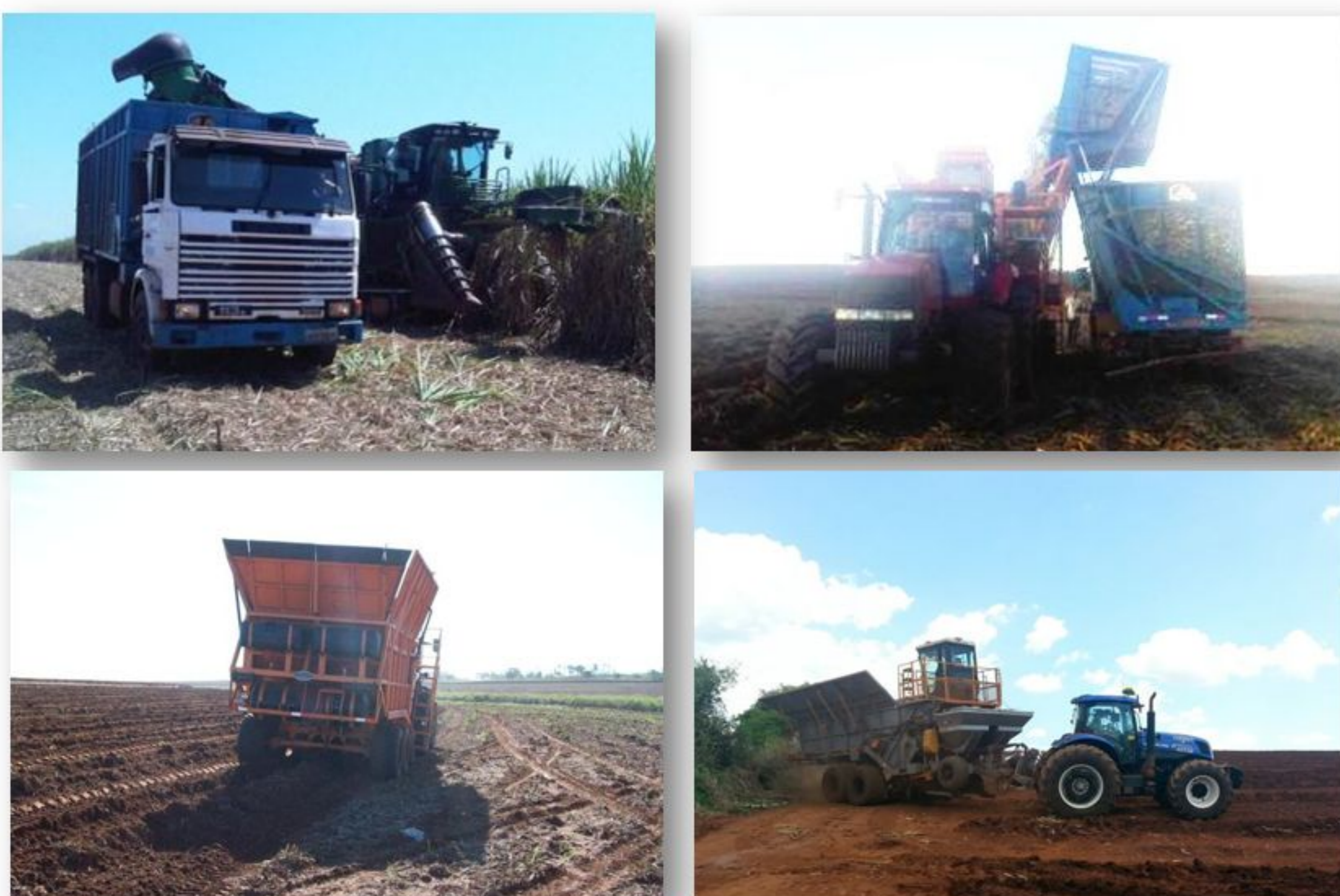
Figura 1 – Imagens da Operação de Plantio
