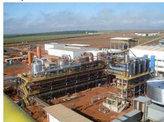
Figura 2: Obra B COSAN (Fonte: Elaborado pelo autor)
