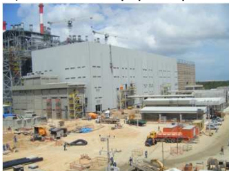
Figura 1: Obra A UTE - Turbina 1 (Fonte: Elaborado pelo autor)
