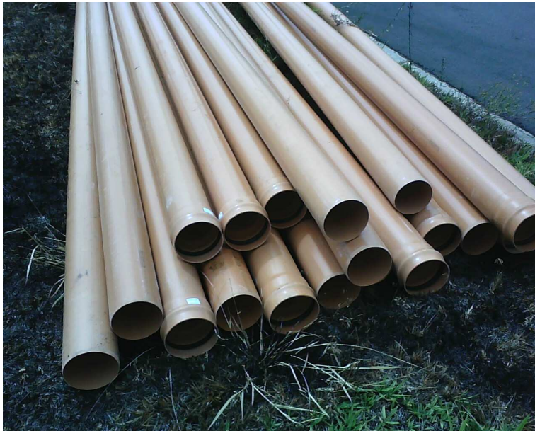
Figura 07: Armazenagem de tubos - Obra Caso 1.
